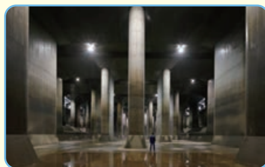
首都圏外郭放水路
