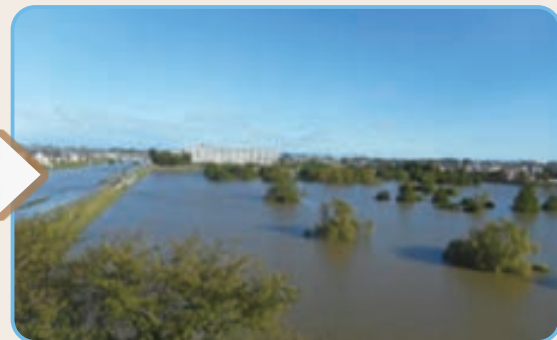
大吉調節池（雨天後）
