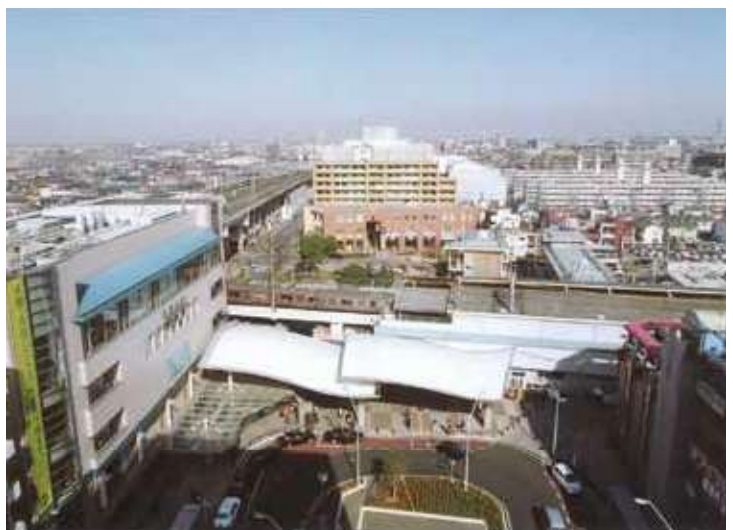
東武鉄道伊勢崎線増連続立体交差事業(新越谷駅付近)
