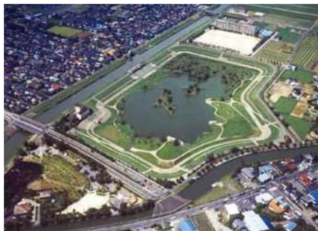
拡幅された新方川と大吉調節池
